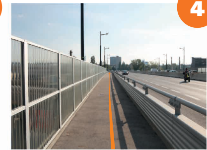
4 Geradeaus weiter, bis zum Ende der Brücke
